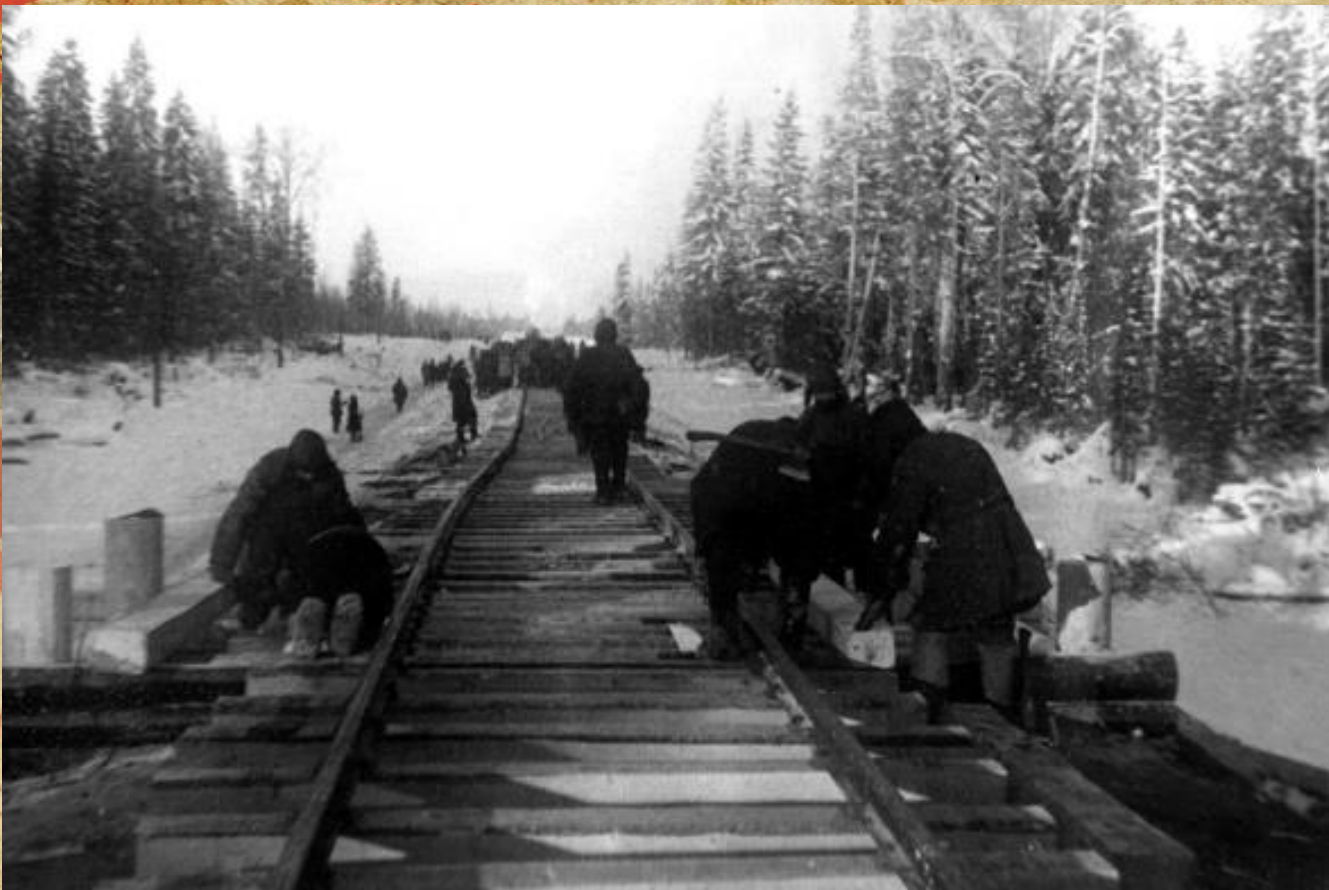
Укладка последних звеньев пути перед смычкой южного и северного участков, 27 января 1943 года.
