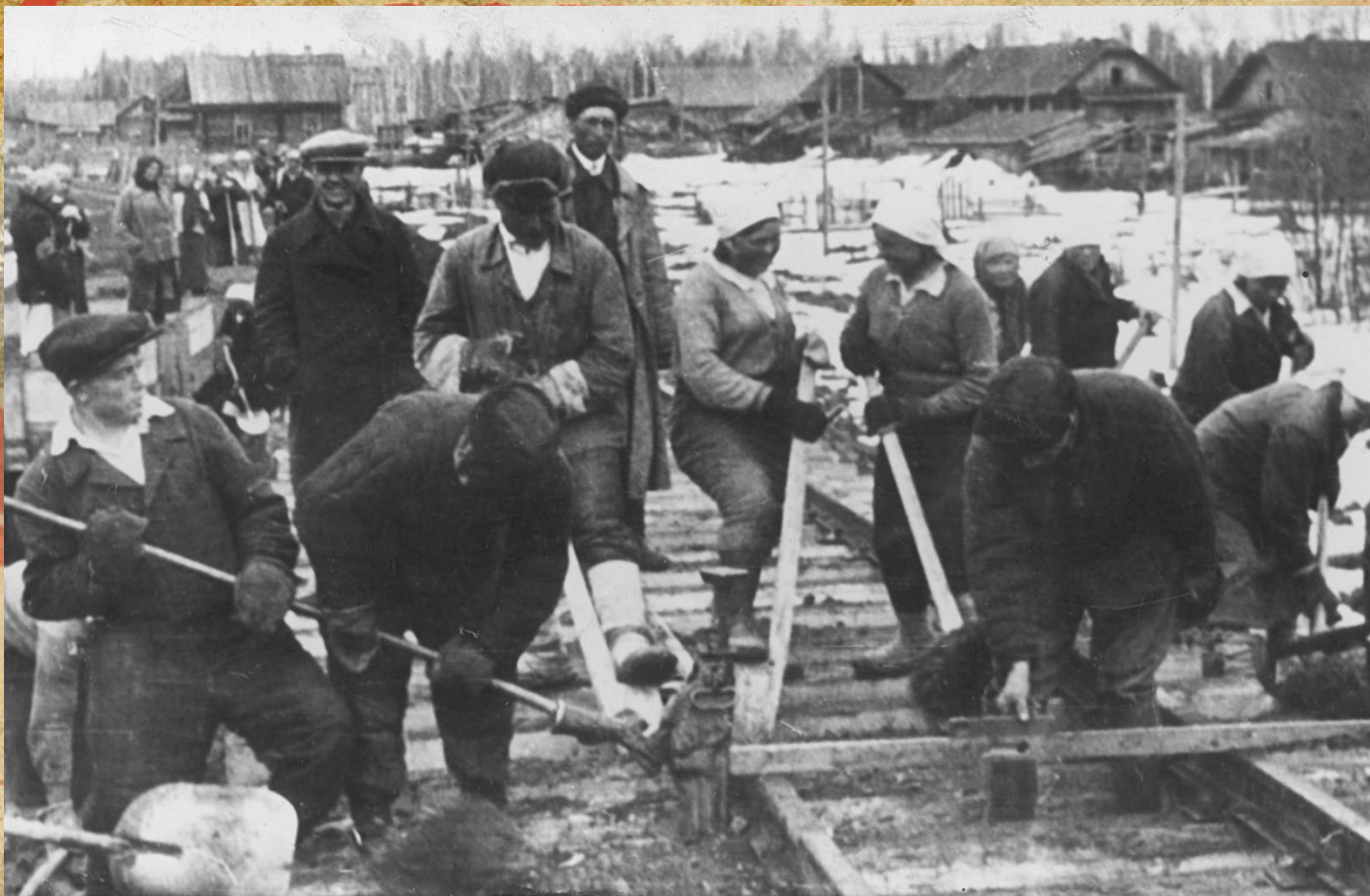
Укладка рельсов на одном из участков железной дороги Ижевск-Балезино.
